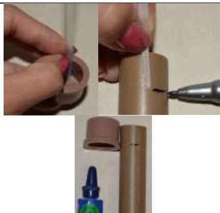
Fig. 11. Determinando a profundidade da conexão e marcando-a sobre a ponta do cano.
